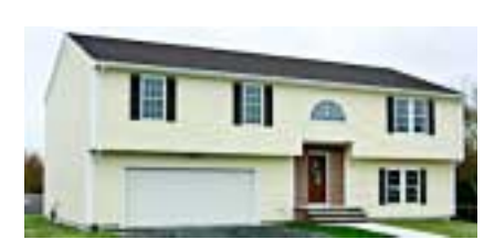
Casas novas em construção
